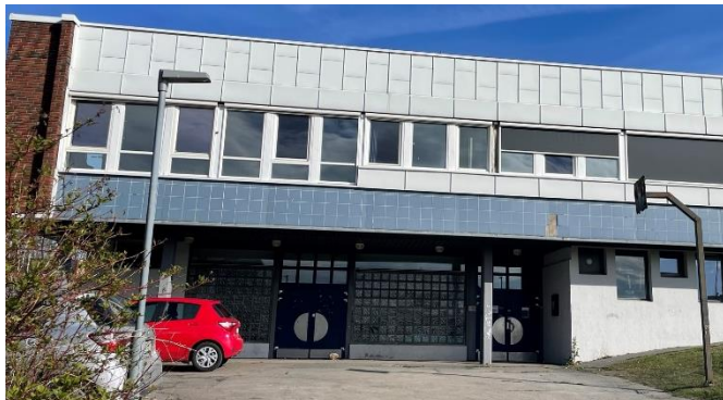
Fasade med glassbyggestein som fjernes og erstattes med tett vegg.
